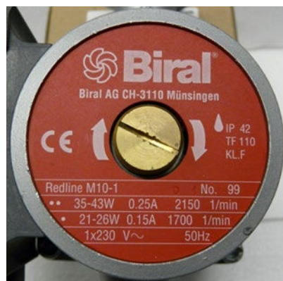
Figura 2: targhetta pompa. Fonte: Biral Redline M10-1
